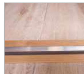
próg dębowy do ościeżnicy drewnianej
