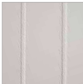
frezowanie na powierzchni skrzydła
