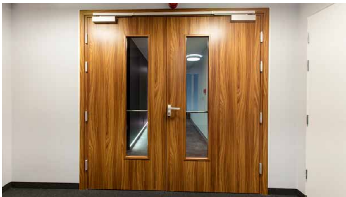
drzwi przeciwpożarowe FR EI30, ościeżnica stała drewniana
