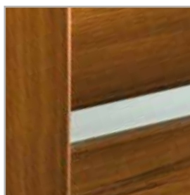
połączenie ramiaka, paneli i szyby
