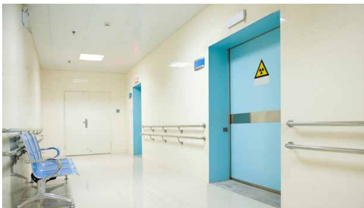
drzwi GAMMA, ościeżnica stała metalowa
