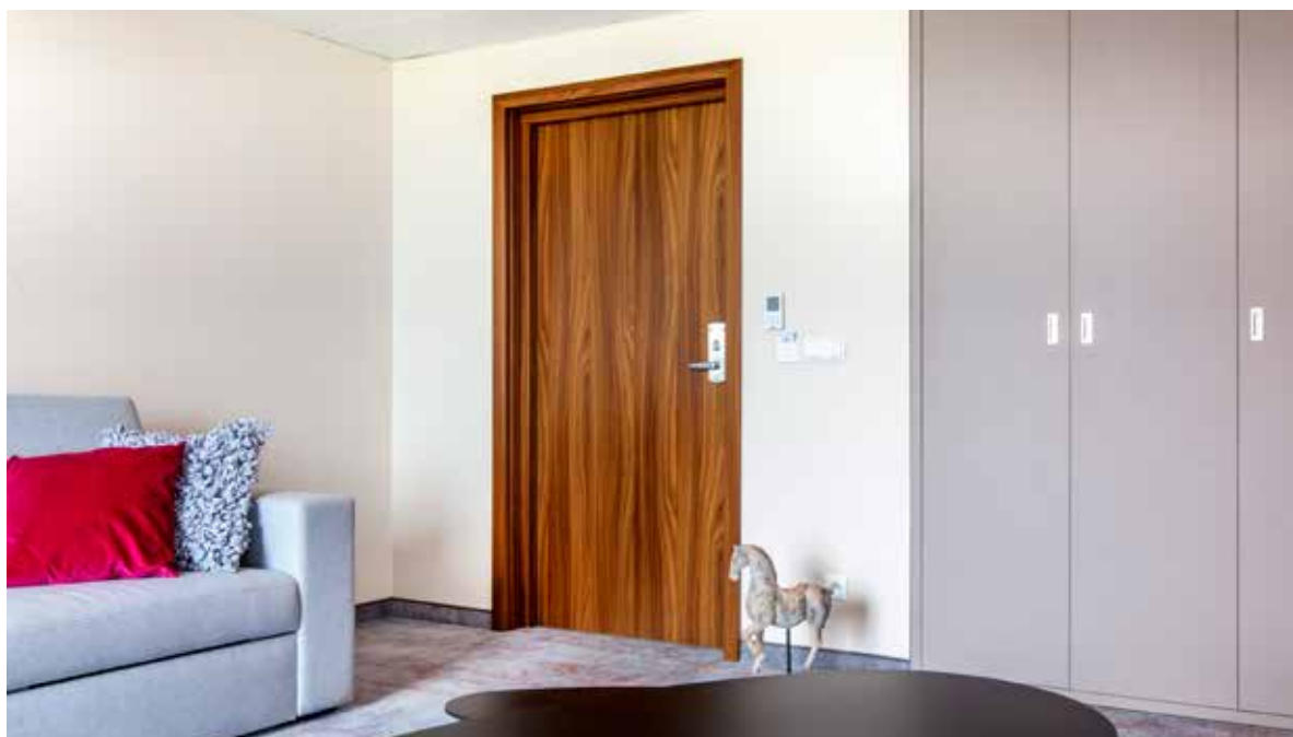
drzwi EI60 PLUS, ościeżnica regulowana drewniana
