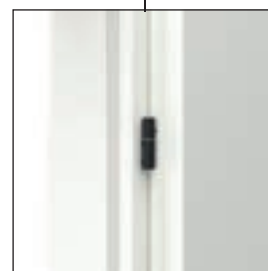
widoczny zawias czopowy
